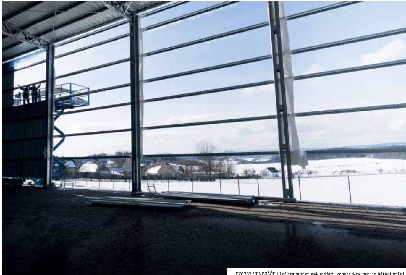
CZ0757 VONDRÁČEK (připravenost sekundární konstrukce pro opláštění stěn)
