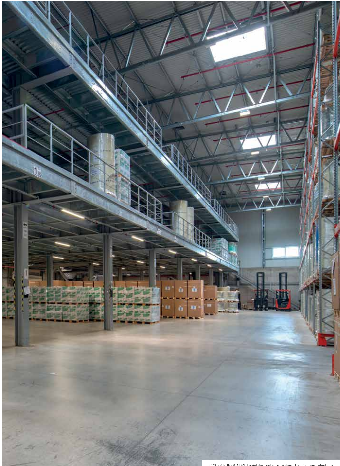
CZ1073 BOHEMIATEX Logistika (patra s nízkým trapézovým plechem)
