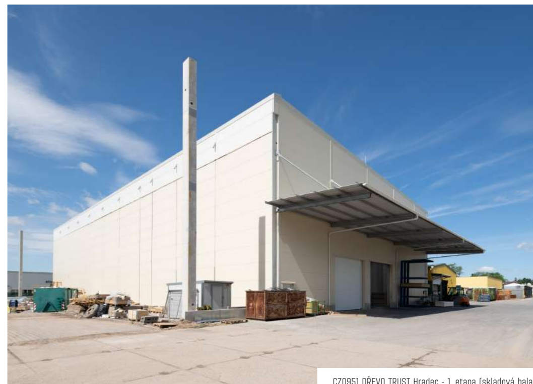
CZ0951 DŘEVO TRUST Hradec - 1. etapa (skladová hala)
