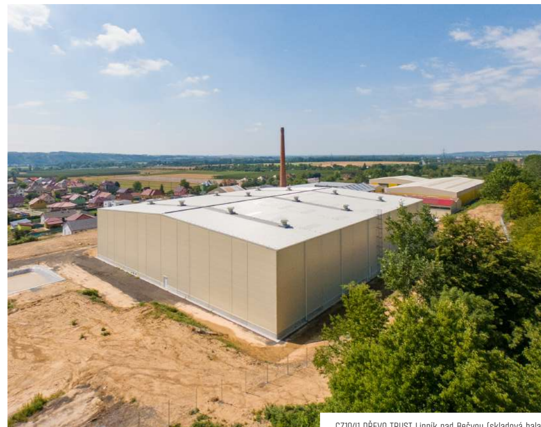
CZ1041 DŘEVO TRUST Lipník nad Bečvou (skladová hala)
